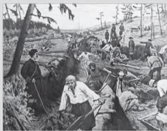
Будівництво Ладозького каналу
